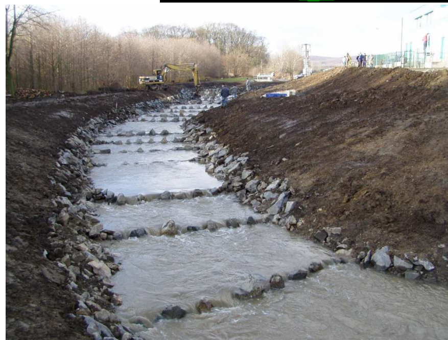
Rybí přechod na Dyji u Bulhar
