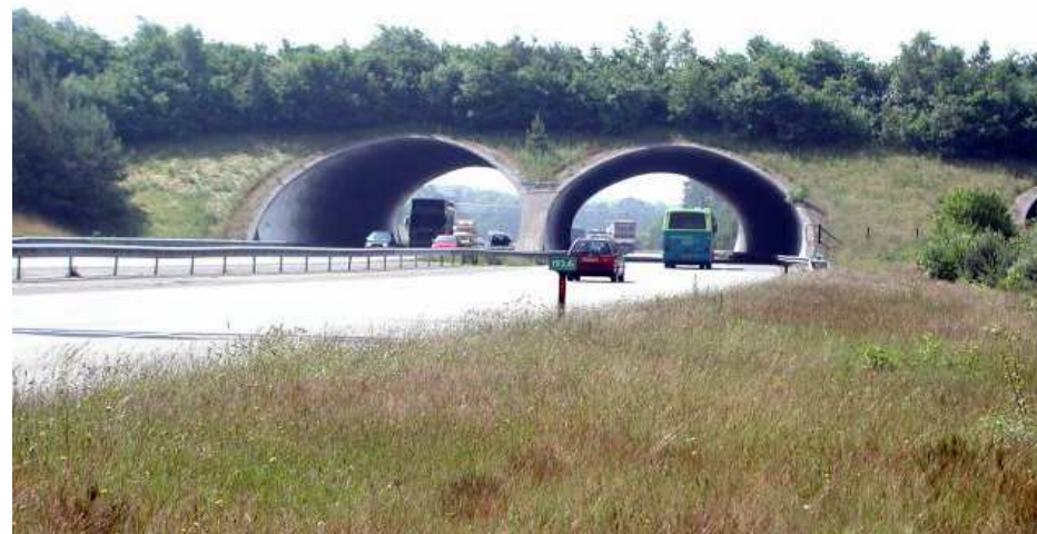
Nadchod pro zvěř na dálnici v Nizozemsku
